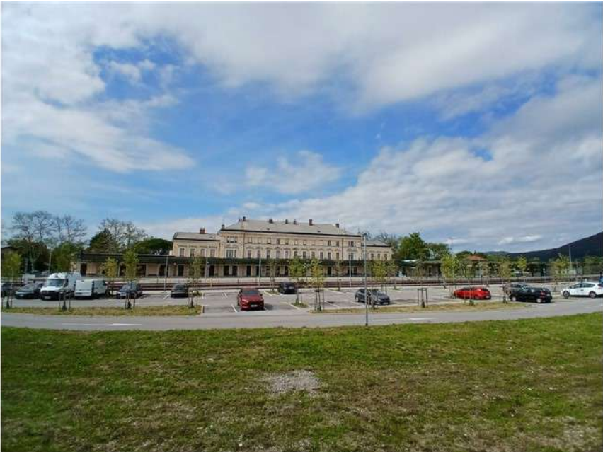
📷 V okviru EPK-ja so obnovili novogoriško železniško postajo. Foto: MMC RTV SLO/Aljoša Masten
